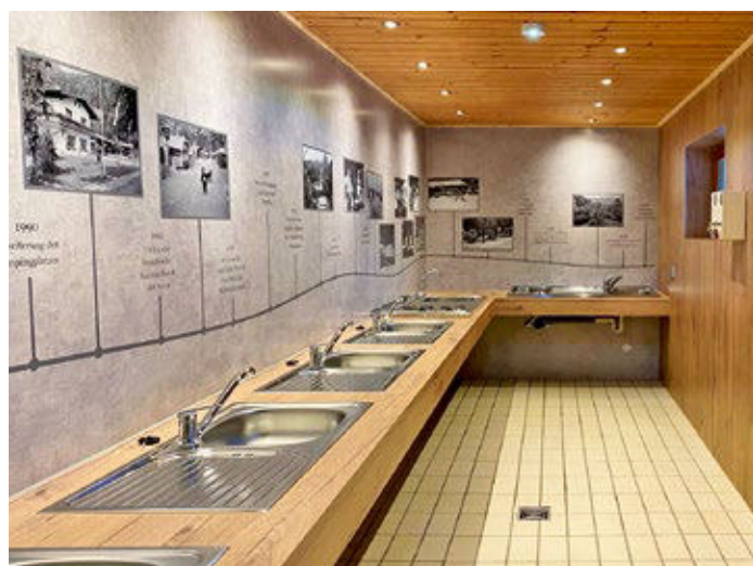
Die Wände wurden mit großflächig bedruckten Aluminium-Verbundplatten optisch reizvoll und besonders schnell saniert.
