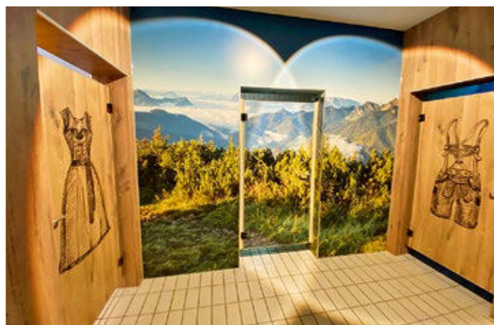
Die Wände wurden mit großflächig bedruckten Aluminium-Verbundplatten optisch reizvoll und besonders schnell saniert.
