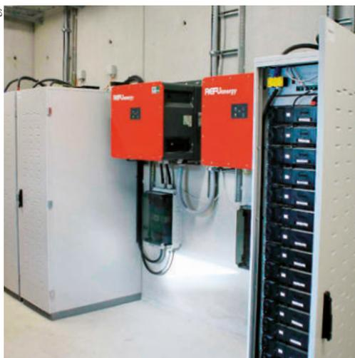
*Batteriespeicher für PV-Anlagen sollten in separaten Räumen nach modernsten Gesichtspunkten installiert werden.*
