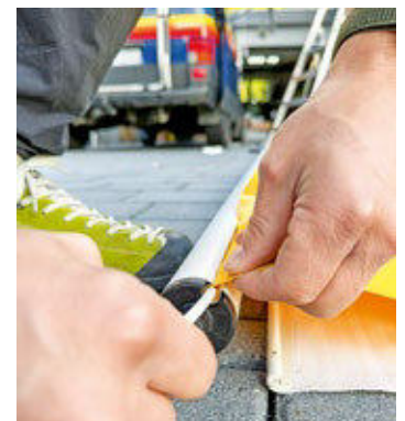
8. Den Keder in die Schlaufe führen ist etwas fummelig, ...
