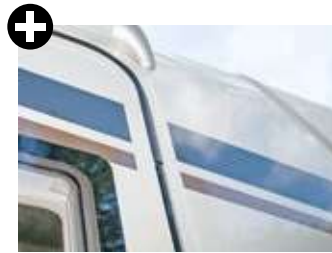
Trockener Einstieg: Die Regenrinne über der Tür leitet Wasser gut ab.
